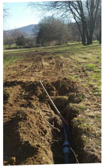
Die Gräben sind gezogen, die Wasserleitung verlegt. Auf der Pipelinetrasse von der „2“ zur „4“ mussten auch schwere Brocken beiseite geräumt werden.
