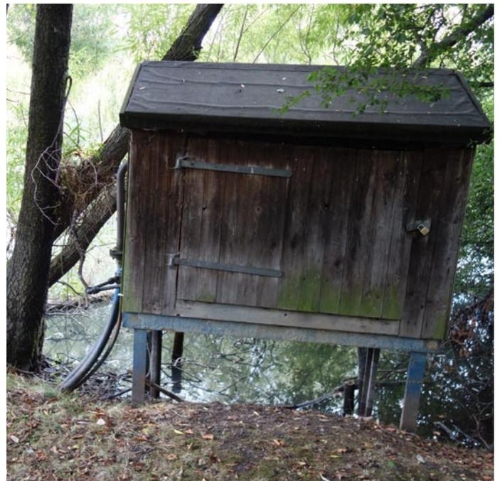
Mittels Pumpe (im Häuschen) und Pipeline wird das Teichwasser hinauf zum Grün der „2“ gedrückt und von dort auf die anderen Bahnen verteilt.
