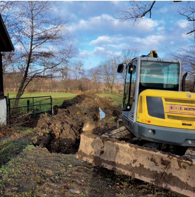
Reparatur der defekten Wasserleitung vom Vorwerk zur Hauptstraße mit Großgeräten und mit eigenen Mitarbeitern.
